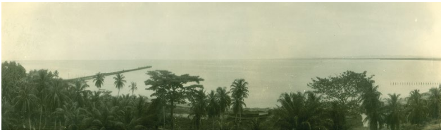
▲ Vista desde Rancho Grande del antiguo (derecha) y nuevo (izquierda) muelle construido para el Packing House . Del antiguo muelle solo se ven los pilotes. 1939. Fuente: Gabriel Moré Sierra.
