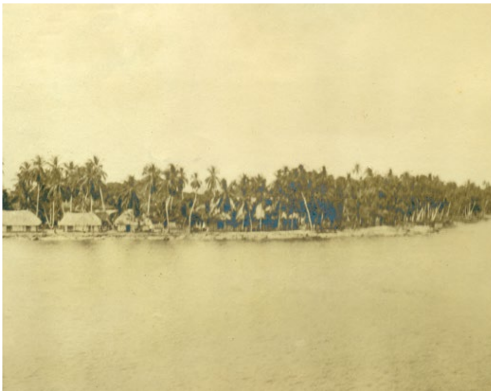
▲ Casa Grande de Madre de Dios, una de las casas de la hacienda de Julián Patrón, quien aprovechó la abundancia de cocoteros a orillas del mar que estaban ahí desde antes de su llegada, cuya exportación era vigilada por peones que habitaban en casas cercanas (lado izquierdo de la imagen). Detrás de estos cocoteros, además del denso manglar, se encontraban las extensas planicies dedicadas al ganado. 1920. Fuente: Gabriel Moré Sierra.
